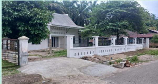
Gambar 3.60 Pembangunan Pustu Batu Mangaum Sungai Garinggiang
