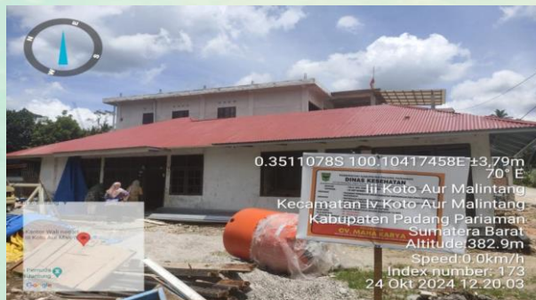
Gambar 3.61 Pembangunan Pustu Durian Jantuang Batu Basa
